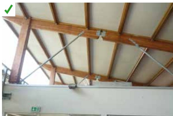
Surtoiture couvrant la toiture existante avec un taux d'ouverture de plus de 5 %. ©AQC
