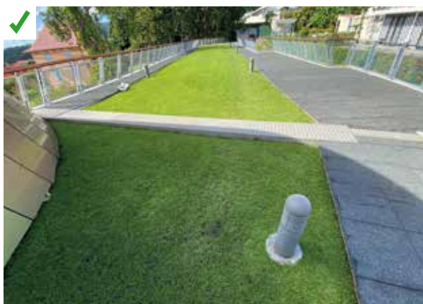
Végétalisation partielle de la toiture. ©AQÇ
