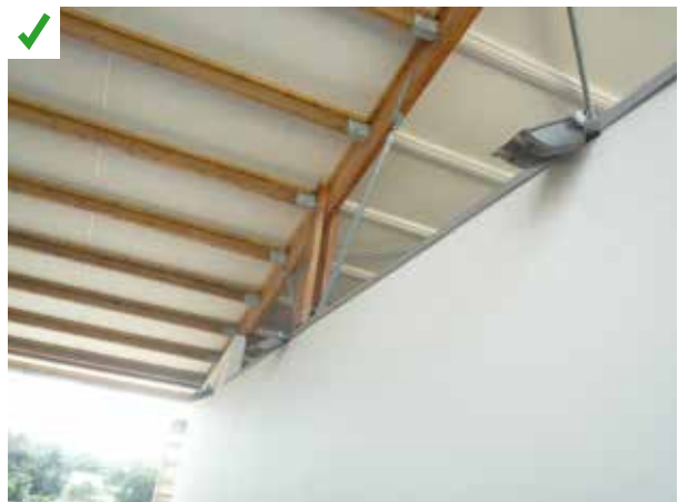
Ajout d'une couverture à un bâtiment existant. L'étanchéité de la dalle est protégée et la surtoiture permet une protection efficace contre les surchauffes. ©AQC
