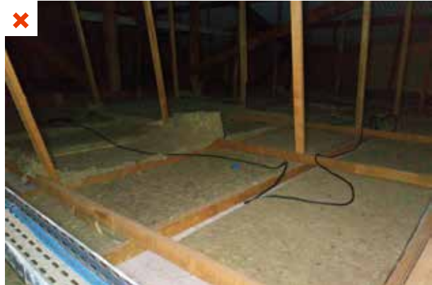
La mise en œuvre de l'isolant n'est pas continue. Certaines surfaces au-dessus du plafond ne sont pas isolées. ©AQC
