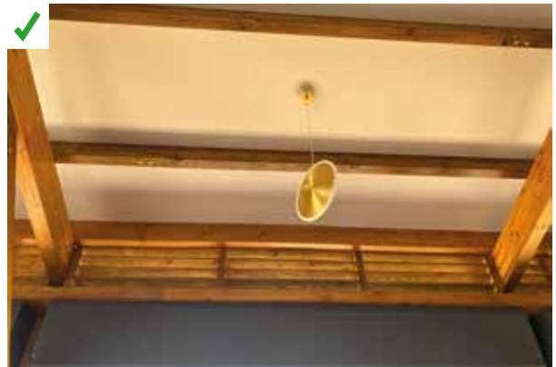
Ventelles sous toiture - Vue intérieure. ©AQC
