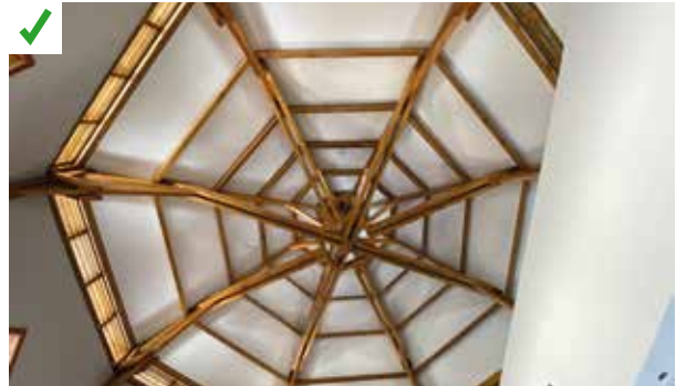
Charpente vue de l'intérieur permettant l'évacuation des charges thermiques. ©AQC
