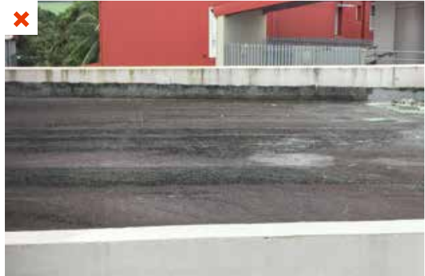
Cette toiture-terrasse présente des défauts d'étanchéité à l'eau et ne dispose d'aucune protection. ©AQC
