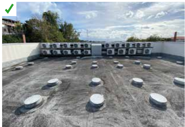
Plots installés sur la toiture-terrasse pour la mise en place de panneaux photovoltaïques afin d'éviter de percer ou de fragiliser l'étanchéité. ©AQC
