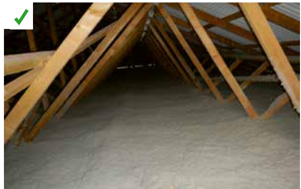
Pose de ouate de cellulose par soufflage permettant une isolation homogène sur toute la surface du plancher haut. Une ventilation des combles est conservée, ce qui permet de réguler les températures et l'hygrométrie. ©AQC
