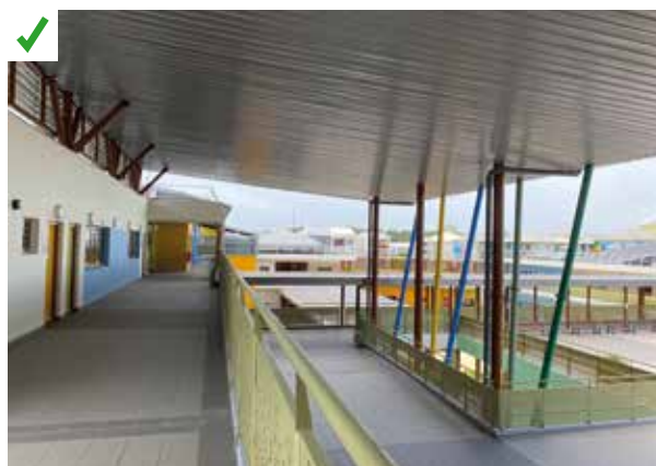
Surtoiture protégeant également une coursive et une partie de l'espace récréatif d'un groupe scolaire. ©AQC
