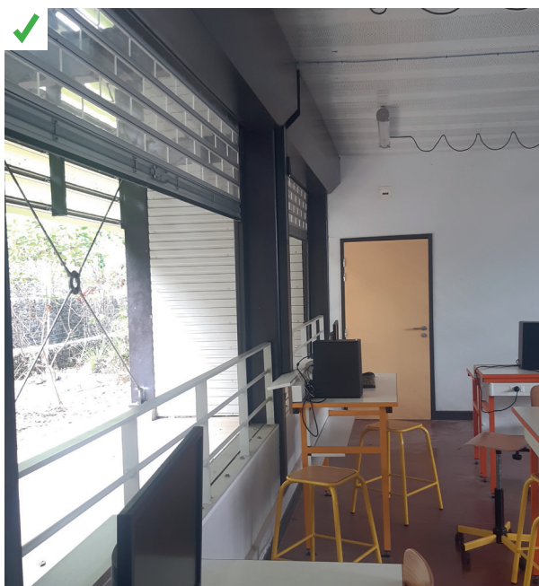
La façade peut s'ouvrir entièrement pour laisser passer les brises et les ouvertures sont protégées de la pluie par des jous. ©AQC
