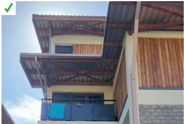
Les murs en béton banché sont protégés des rayonnements solaires directs par des auvents. ©AQC
