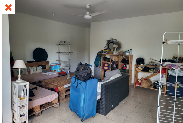
Le salon est peu utilisé par les usagers qui ressentent une température trop élevée même lorsque le brasseur d'air fonctionne. ©AQC
