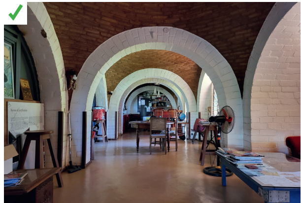
L'intérieur de l'habitation ne possède ni climatisation ni brasseurs d'air, mais reste agréable tout au long de la journée, car les murs et planchers hauts sont à fortes inerties (voûtes en BTC entre 14 et 45 cm d'épaisseur). ©AQC
