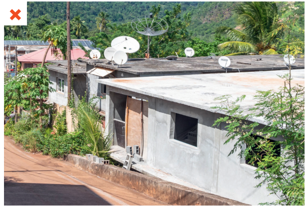
L'enveloppe de cette maison est entièrement conçue en béton (toiture et murs verticaux). ©AQC
