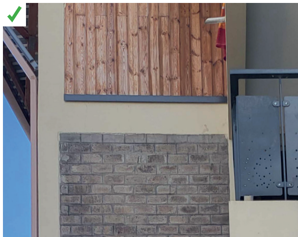
Dans l'épaisseur du joint, un fer plat scelle les briques de terre comprimées à l'ossature en béton. ©AQC
