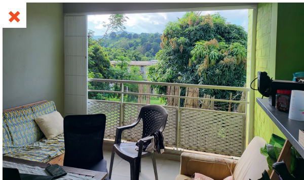
La varangue est la pièce de vie principale du logement. Lorsqu'il pleut, l'eau stagne sur le sol et le mobilier est mouillé. ©AQC
