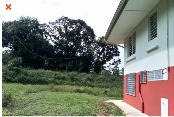
La paroi ouest n'est pas protégée du soleil direct. ©AQC
