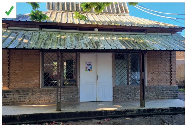
La façade est protégée des rayonnements solaires directs par un auvent. ©AQC
