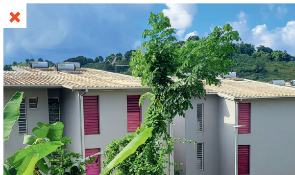
Les murs extérieurs des chambres sont composés de béton banché de 18 cm dont la conductivité thermique ( \lambda : 1,1 \text{ W/m.K} ) est supérieure à celle des briques de terre comprimées ( \lambda : 0,46 \text{ W/m.K} ). ©AQC
