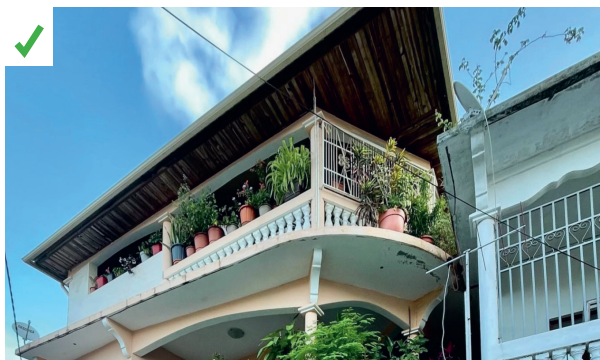
Varangue protégée de la pluie par un large débord de toiture. ©CAUE
