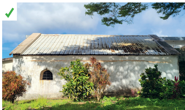
Les murs de la mosquée ont été construits au XVI ème siècle en pierre de corail. Le choix de ce matériau limite l'entrée de chaleur à l'intérieur de l'édifice. La conductivité thermique d'une pierre calcaire est en moyenne de \lambda : 3,5 \text{ W/m.K} . ©AQC
