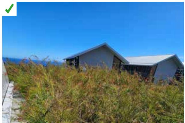
Toiture végétalisée isolée vis-à-vis du risque incendie avec bande stérile, point d'eau à proximité et d'accès simplifié. ©AQC
