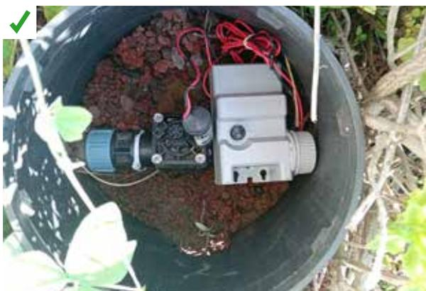
Programmeur bluetooth sur électrovanne permettant un pilotage de l'irrigation adapté aux besoins. ©AQC
