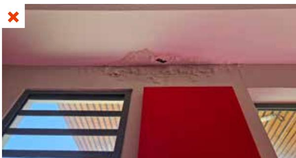
Infiltration sous toiture végétalisée. ©AQC
