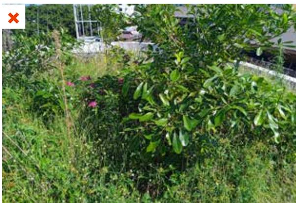
Développement spontané en toiture d'un arbre dont les racines perforent la membrane d'étanchéité à l'eau entraînant des infiltrations. ©AQC
