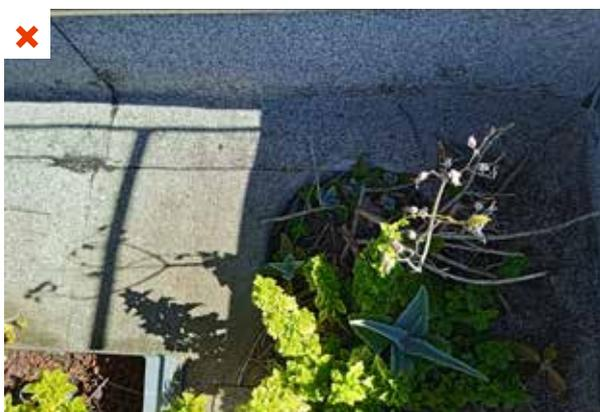
Développement de végétaux sur la zone stérile à proximité de l'évacuation des eaux pluviales. La présence de végétaux ne permet pas de contrôler l'intégrité de l'étanchéité au niveau de la zone stérile et des relevés d'étanchéité. Le développement des végétaux risque d'altérer l'étanchéité et ne permet pas une bonne évacuation de l'eau de pluie. ©AQC
