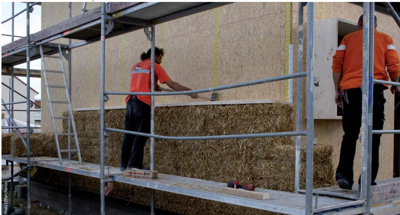
Les bottes de paille sont maintenues par des éléments horizontaux dont l'espacement est dépendant de leur masse volumique et du taux de compression qui leur est appliqué. Ces éléments sont fixés aux montants d'ossature ou à la structure.
