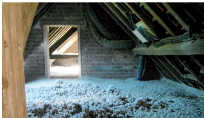
Comble non aménagé isolé avec un isolant insufflé en ouate de cellulose
