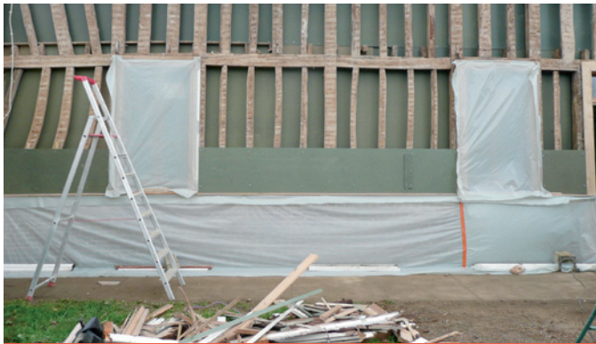
Une fois le torchis déposé, l'ossature réparée, les protections et les premières banches sont mises en place pour recevoir un béton biosourcé.
