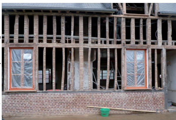
2) Sur cette maison picarde, les murs ont été mis à nu, les colombages et la maçonnerie ont fait l'objet de réparations, l'ossature est prête à recevoir un béton biosourcé.
