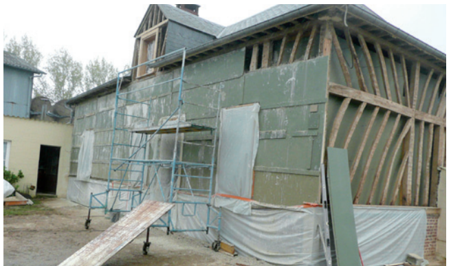
Les banches s'élèvent au fur et à mesure du remplissage des pans de bois.
