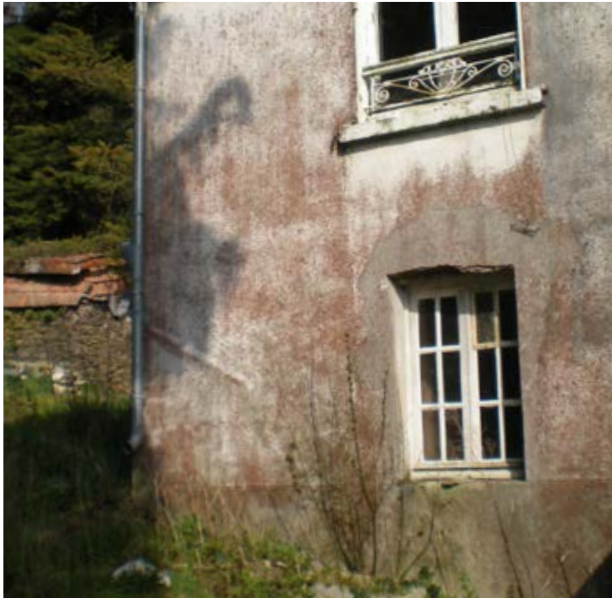
9. 10 Développement de moisissures suite à mise en œuvre de matériaux inadaptés étanches à la vapeur d'eau : enduit extérieur et peinture intérieure
