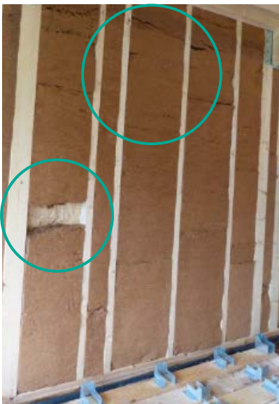
18. 19. 20. Tassement de la fibre de bois suite à une arrivée d'eau en toiture en cours de chantier
