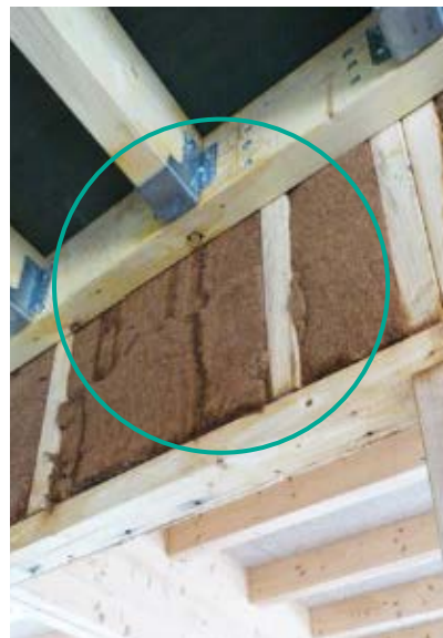
18. 19. 20. Tassement de la fibre de bois suite à une arrivée d'eau en toiture en cours de chantier
