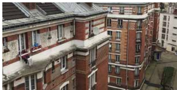
HBM Façades en briques
