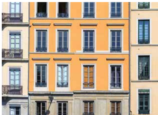
Construction en pierre
