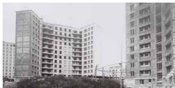
HBM Façade en remplissage brique puis parements en béton
