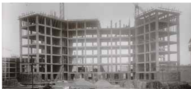
HBM Structure poteaux-poutres en béton
