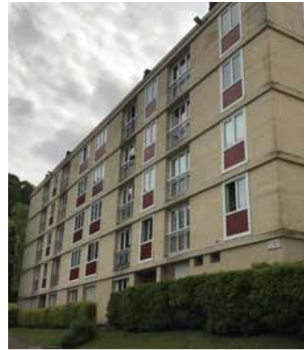
Construction en béton des années 60
