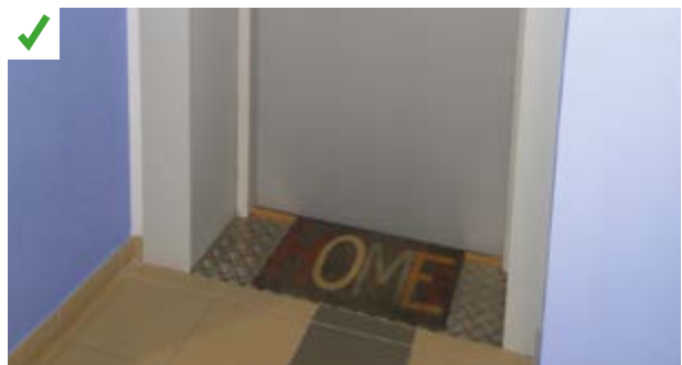
Une plaque métallique au niveau de la porte palière permet de traiter proprement la jonction de plancher entre les logements réalisés à base de modules et le noyau central de distribution réalisé sur chantier. ©AQC
