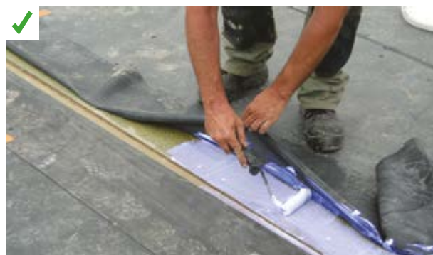
Étanchéité d'une toiture-terrasse : les membranes d'étanchéité des modules sont pré-positionnées et les jonctions entre modules sont étanchées dès que ceux-ci sont correctement posés et connectés entre eux. ©AQC
