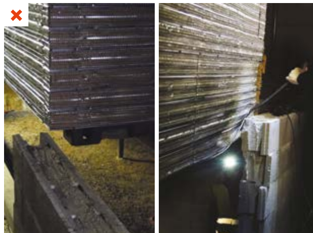
Le dernier module à être posé ne « rentre » pas dans l'espace alloué : il faut trouver du jeu en décalant les modules déjà posés. ©AQC
