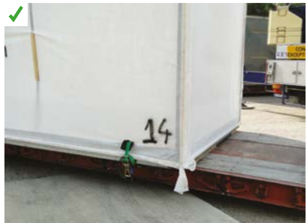
Module bâché pour le transport avec son numéro de repérage. ©AQC
