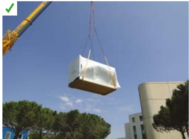
Les modules en cours de pose sont bâchés. ©AQC
