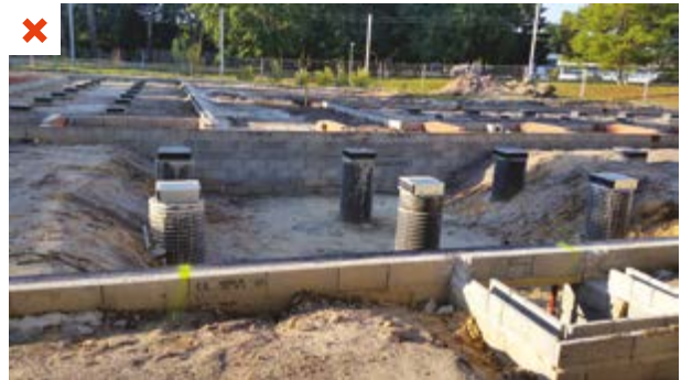
La conception des fondations de ce chantier a été revue après la passation du marché de travaux pour répondre aux prescriptions du système modulaire. ©AQC
