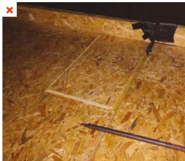
Sur cette toiture-terrasse, l'étanchéité reste à faire. Sans protection, elle est soumise aux intempéries. ©AQC
