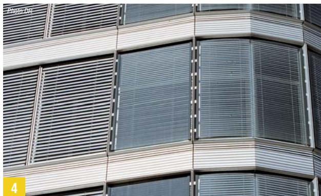
**1** Les brise-soleil horizontaux en projection au-dessus des baies s'appliquent aussi bien pour le tertiaire que le logement.
