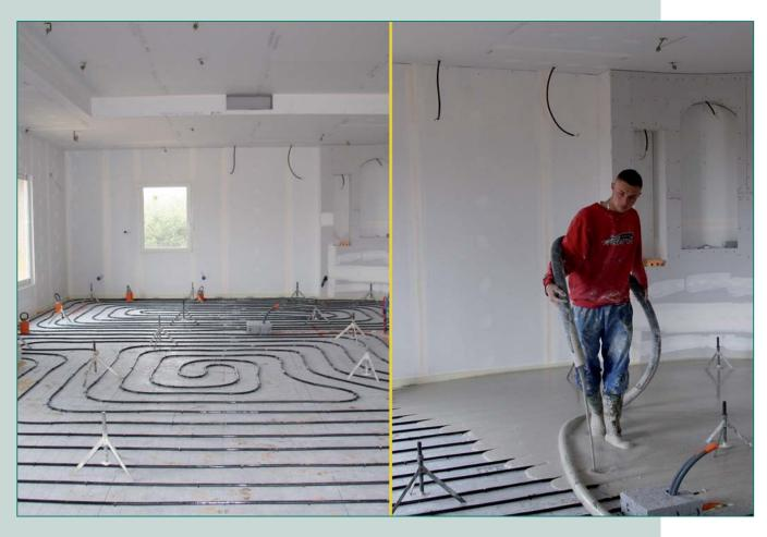
port à une chape traditionnelle, la montée en température est plus rapide, et la régulation plus fine. Les temps de séchage peuvent être également réduits par rapport aux chapes traditionnelles, un atout qui doit néanmoins être géré avec rigueur sous peine de désordres.
