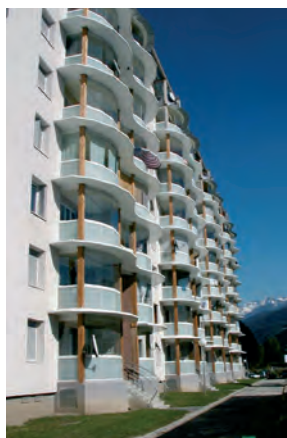
Vérandas balcon: vue extérieure
