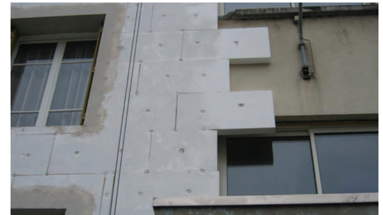
Pose d'une isolation thermique extérieure en façade
