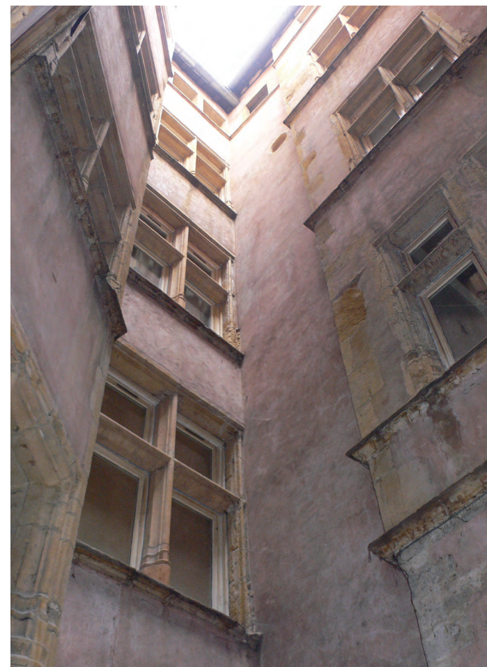
Cour intérieure du n° 58 rue Saint-Jean à Lyon, bâtiment de logements sociaux situé en zone ZPPAUP / Patrimoine mondial de l'Unesco. Cas d'une opération d'amélioration thermique impliquant des choix déterminants en terme de restauration du patrimoine.
