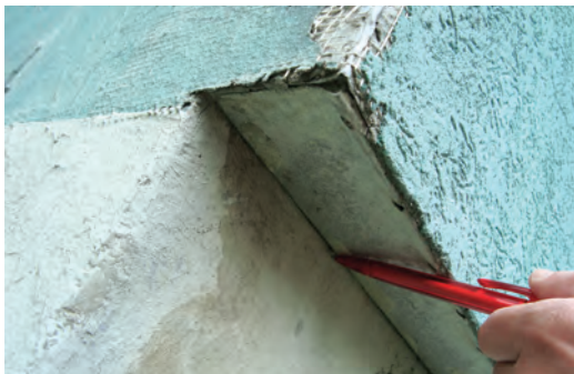
Isolation thermique extérieure en pignon à conserver.
