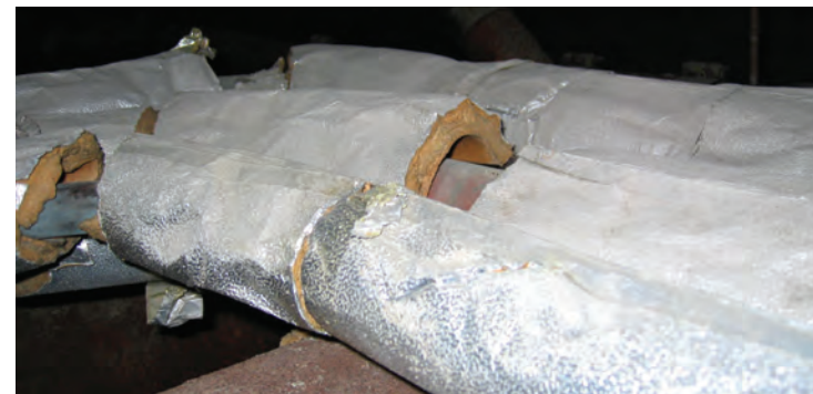
Calorifuge déficient
