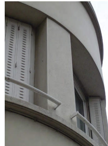
Étude ITE et détail de modénature sur baies et balcons Logement social, Groupe Perrache, Lyon (69).
