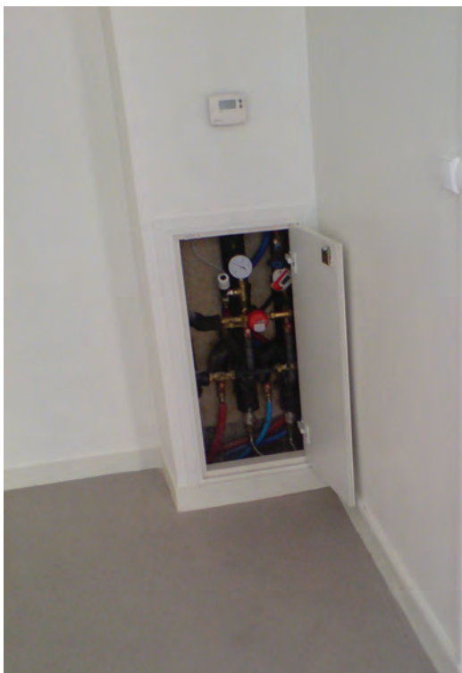
Placard technique en logement pour réglage, équilibrage et comptage des consommations.
