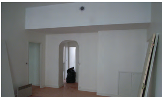
Création d'un réseau de ventilation double flux centralisé
