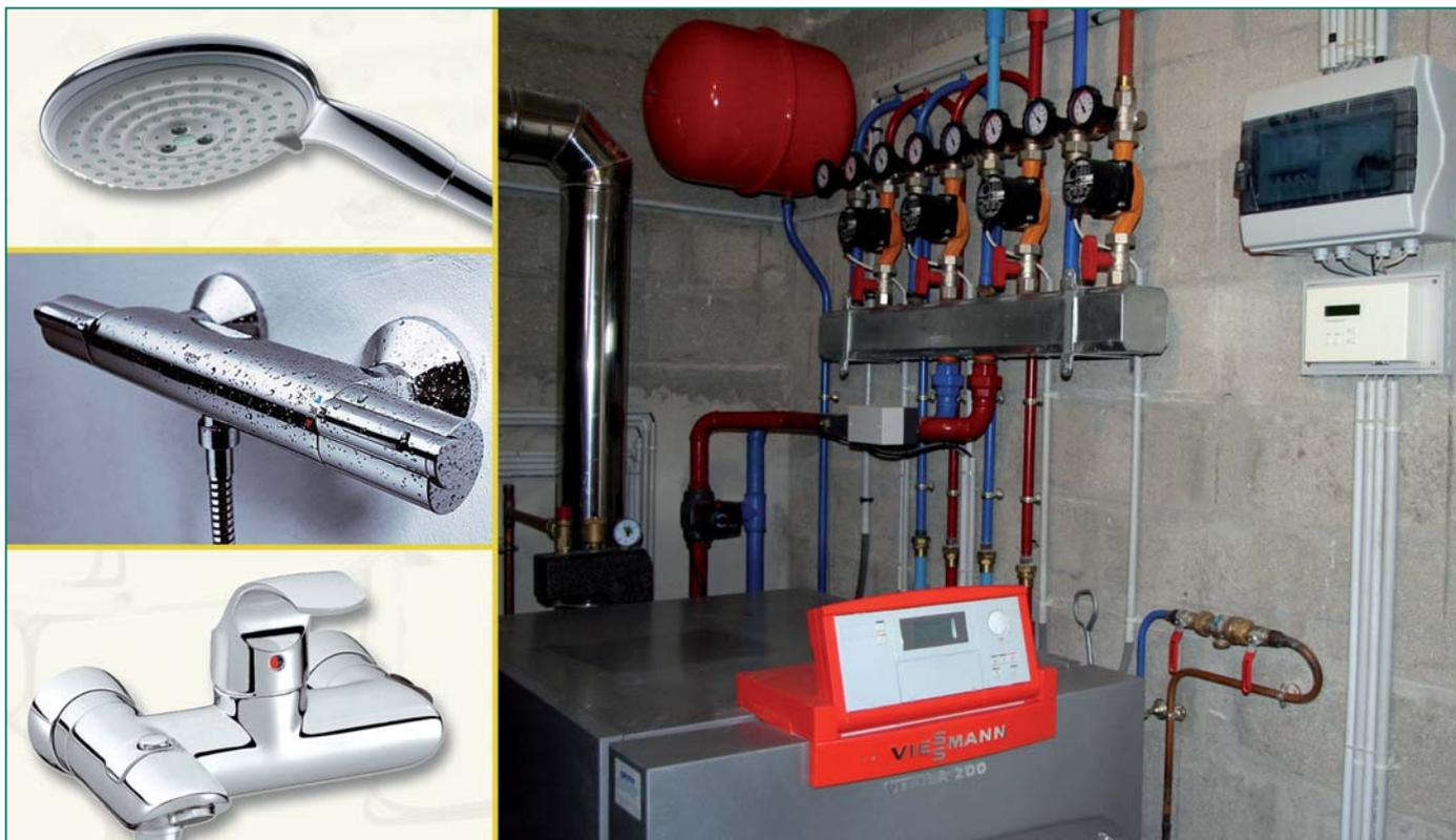
Les chocs chlorés consistent à hyperchlorer les réseaux pendant 24 heures avec du chlore à la concentration de 15 ml/l. Le choc thermique vise à élever la température de l'eau chaude à 70° en sortie de tous les points d'eau, en laissant couler environ trente minutes l'eau chaude portée à cette température dans tout le réseau.
