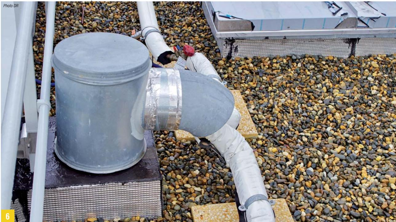
**6** Pour éviter la pénétration d'eau par les traversées de toiture-terrasse, la crosse est une solution éprouvée et parfaitement efficace.
