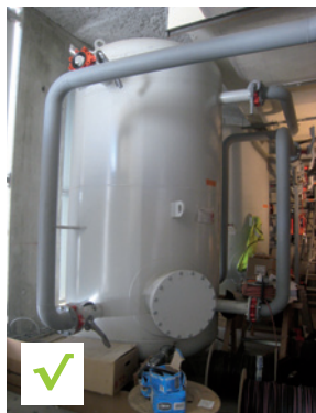
Installation d'un ballon tampon afin de compenser le surdimensionnement du système de chauffage existant.
