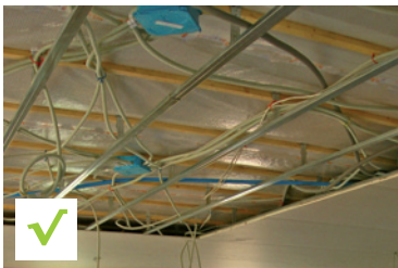
Illustration d'un vide technique permettant le passage des réseaux sans percement de l'enveloppe.
