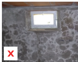
Développement de micro-organismes suite à l'installation d'une menuiserie neuve dans une cave non ventilée.
