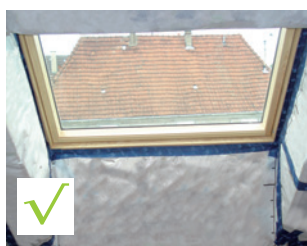
Traitement complet de l'étanchéité entre le châssis de la menuiserie et le «tableau».
