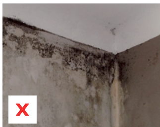
Apparition de moisissures suite aux changements des menuiseries sans mise en place de VMC.
