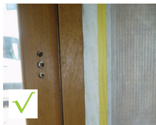
Continuité de l'étanchéité à l'air assurée avec l'utilisation d'un adhésif adapté.
