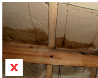
Vapeur d'eau qui a condensé dans l'isolant suite à l'exfiltration d'air au niveau du faîtage. Photo prise après démontage du lambris.
